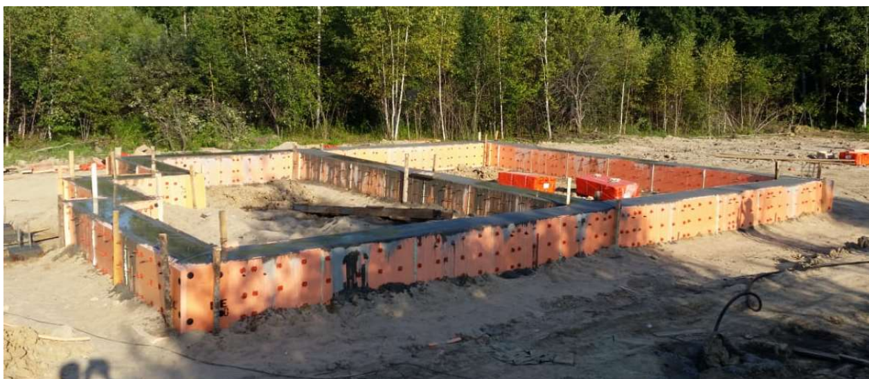
Рис. 7 Конструкция после заливки
