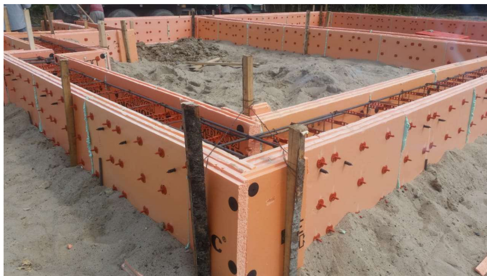
Рис. 4 Укрепление угловых элементов опалубки
