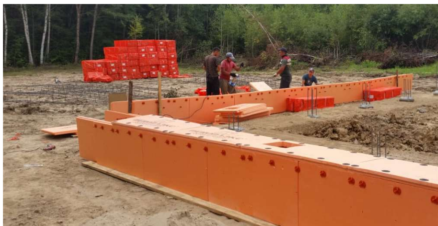
Рис. 1 Сборка несъемной опалубки
