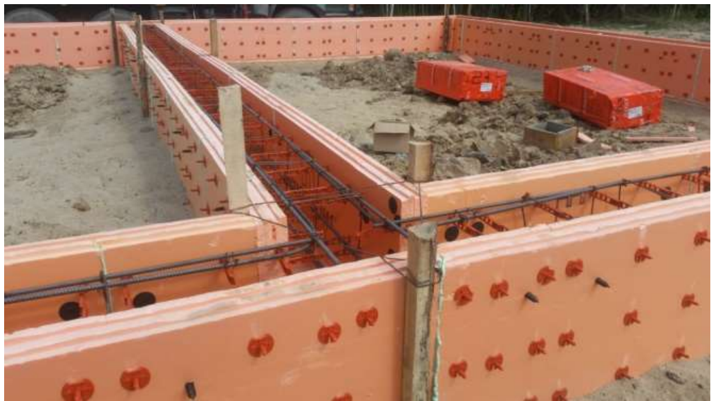
Рис. 6 Укрепление Т-образных углов опалубки
